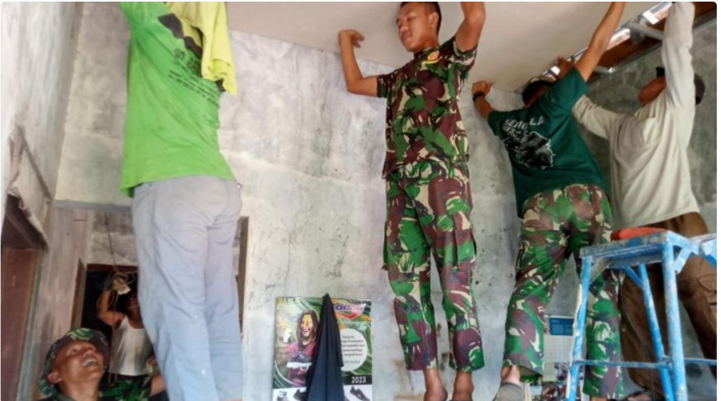
*(Foto Istimewa) Pemasangan Plafon RTLH TMMMD 116 Kodim 0722/Kudus*
